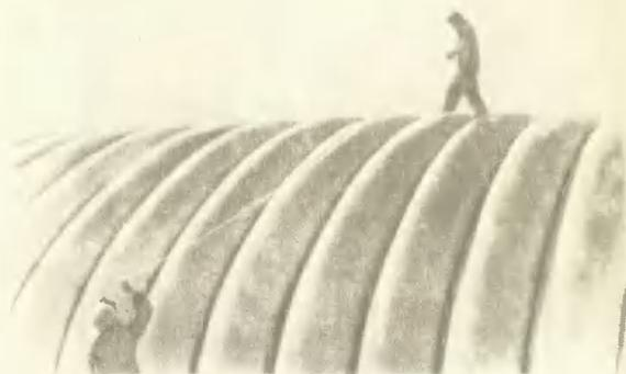
**ЭТО НЕ АВТОМОБИЛЬНЫЕ ШИНЫ,** а теплица. Она собрана из так называемых скорлуп — отдельных секций из полиэфирного стеклопластика. Но готовая теплица площадью 12×24 м совсем не так хрупка, как скорлупа. Никаного поддерживающего каркаса ей не нужно. А света она пропускает достаточно — примерно 85% (ГДР).
